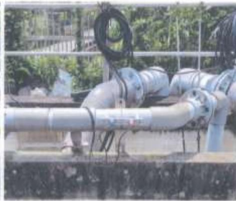
圖二、標準量測計器攜帶型超音波流量計安裝
